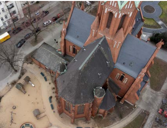
Sankt Ludwig, dritter Bauabschnitt
